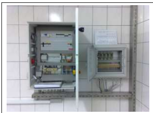
Slika: VH ŠKALCE 2 – Elektroinstalacijska oprema
