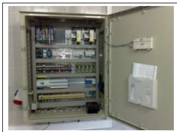
Slika : PČP ŠKALCE-1 el. oprema za Telemetrijo
